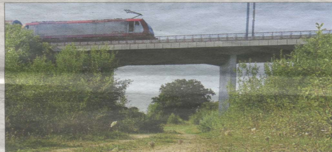
Geburtstag für die künftige Eisenbahnbrücke. Seit zehn Jahren ist diese nun fertiggestellt.
