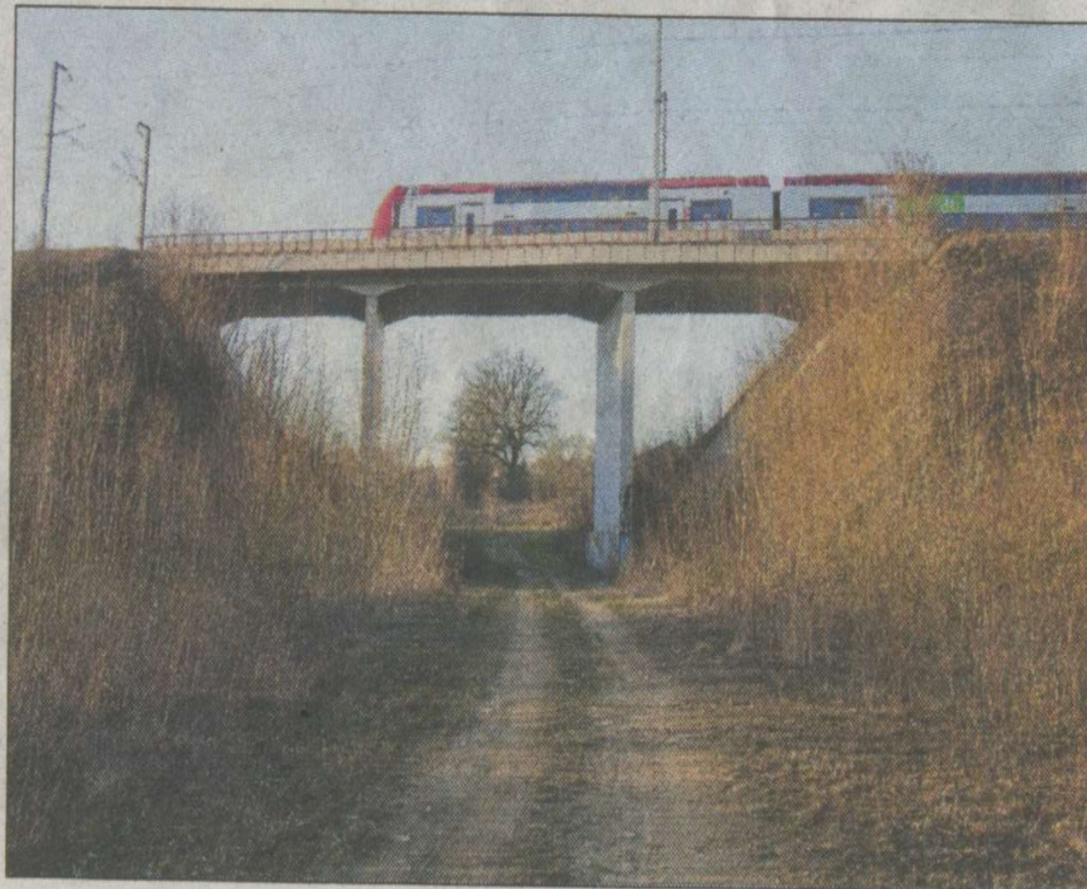
Unter dieser Brücke soll die Umgehung von Dippach-Gare einmal hindurchführen.
